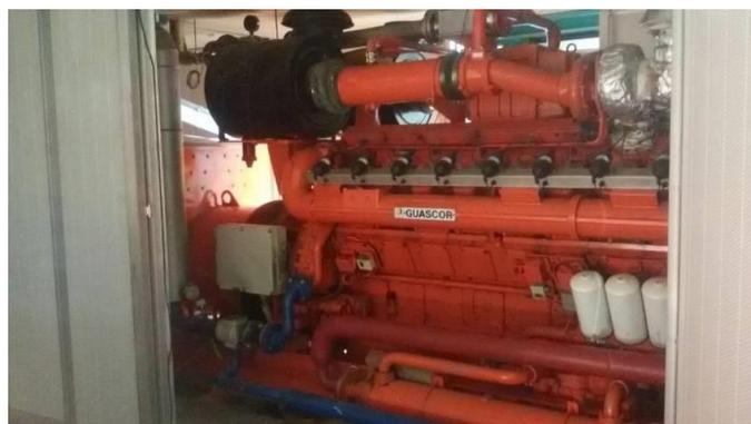
Negli impianti di cogenerazione (COGE) vengono prodotti **contemporaneamente sia energia elettrica che calore** secondo il principio dell'abbinamento forza-calore.
