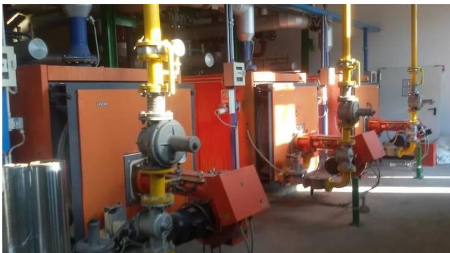
Ad integrazione nei momenti di maggior richiesta da parte della rete l'impianto integra la produzione di energia termica mediante delle caldaie a gas
